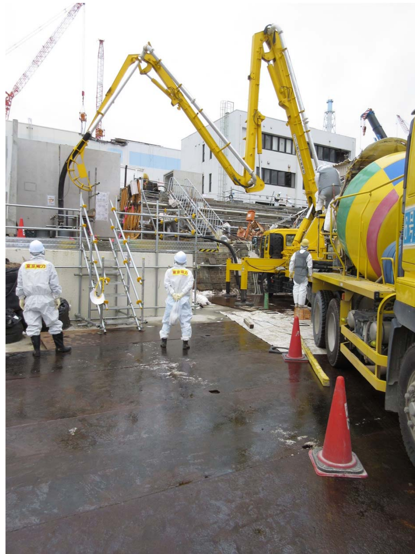
3号機海水配管トレンチ 閉塞充填作業の様子
